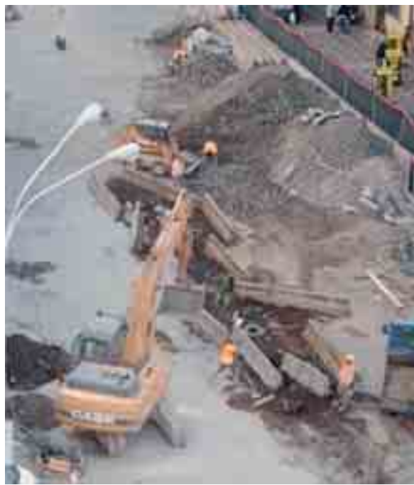
A sinistra, nel tondo, il segretario provinciale della Feneal Uil (il sindacato degli edili) Francesco De Martino. Sopra, lavori in corso al centro della città
